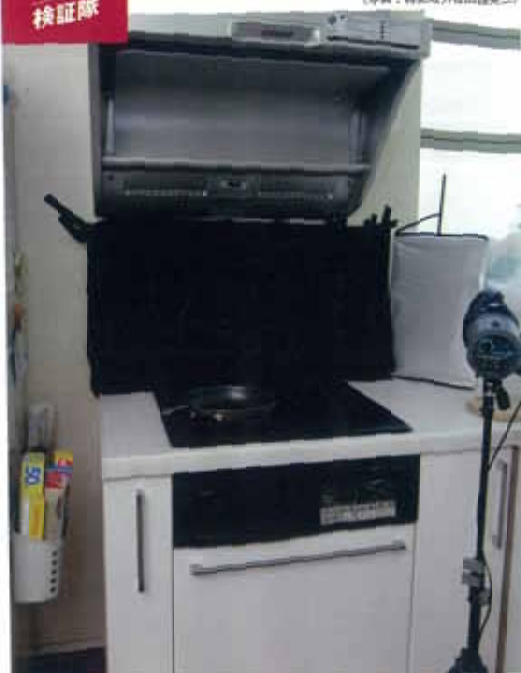
A邸のキッチン。換気風道を出して換気力を高める壁流板方式のIH調理器対応のレンジフードが設置されていた
